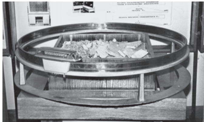
Фото 2. Модель транспортного екіпажу з лінійним асинхронним електродвигуном (ВДНГ СРСР, 1974 р.)
